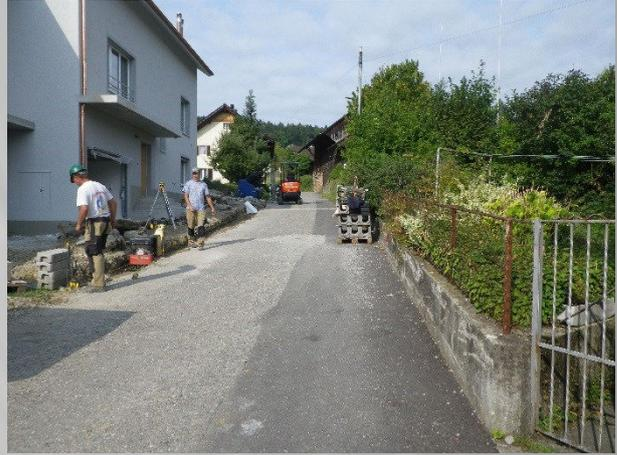
Der Belag muss auf seinen PAK-Wert untersucht werden, da die Entsorgung von PAK-haltigen Belägen mit hohen Kosten verbunden ist. Die Strasse erhält zudem neue Randabschlüsse und eine neue Strassenentwässerung. Im Bereich der neuen "Überbauung Eich" soll die Strasse um 50 cm verbreitert werden, mit dem Ziel, die Strassenbreite auf 4.50 m auszuweiten. Dafür ist ein Landerwerb erforderlich.
